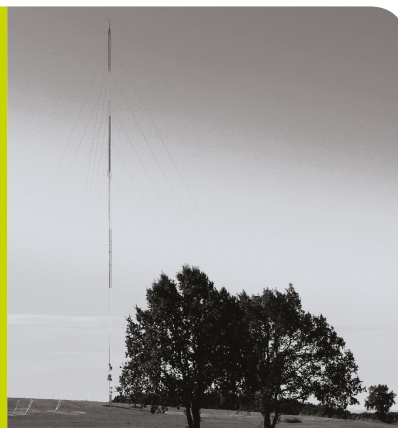
Les instruments en place sur le mât de mesure ont permis d'estimer une vitesse moyenne représentative à 100 m de hauteur supérieure à 7 m/s.
